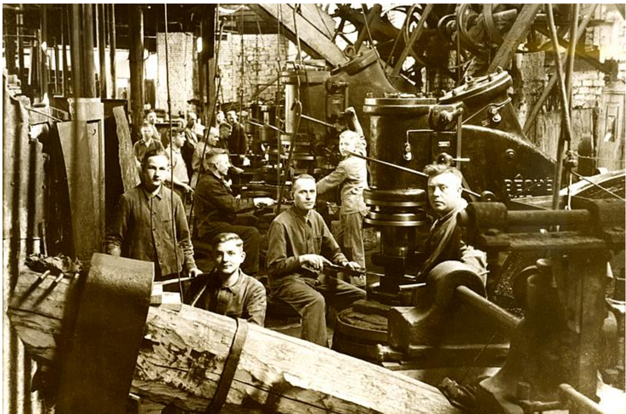
Blick in den Fertigungsbereich, Recken und Breiten im Müscheder Sophienhammer um 1950. Original: Fa. Cronenberg, Müschede. Weitere Bilder zur Sensen-Produktion ...
