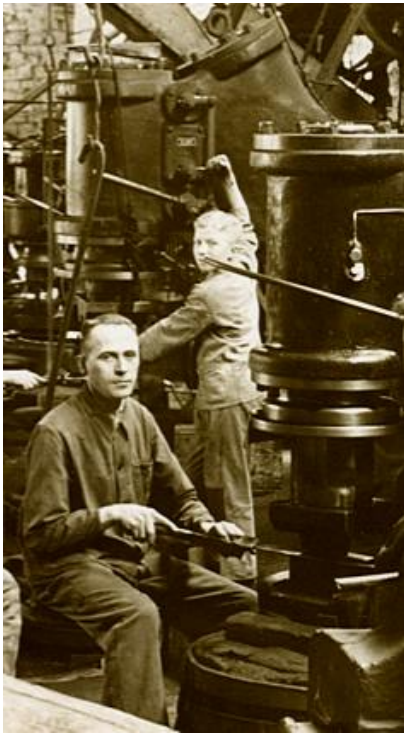
Müscheder Sensenschmiede auf dem Sophienhammer bei ihrer Arbeit (Recken, Breiten, Glattschmieden, Klippen, Schleifen, Polieren, Lackieren, Versand) . Die Lehrlinge schauen den erfahrenen Sensenschmieden über die Schulter. Original: Firma Cronenberg, Müschede.
